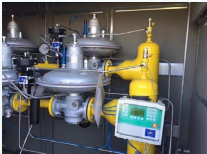
fig.7: l'apparato FIO 2.0 installato in una cabina di distribuzione
